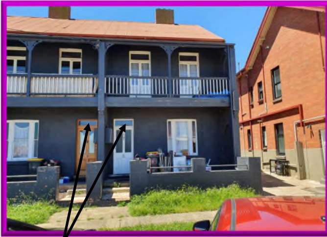
Transom light above door
